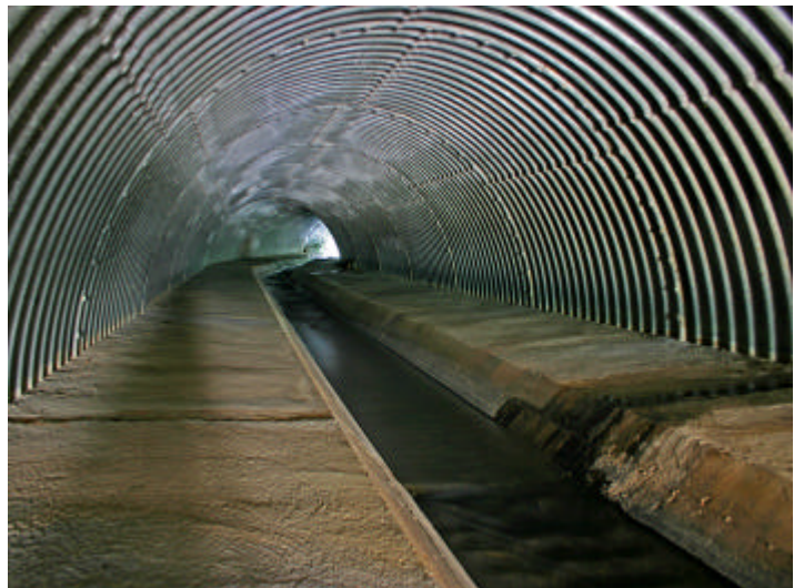
Chenal avant l'aménagement
