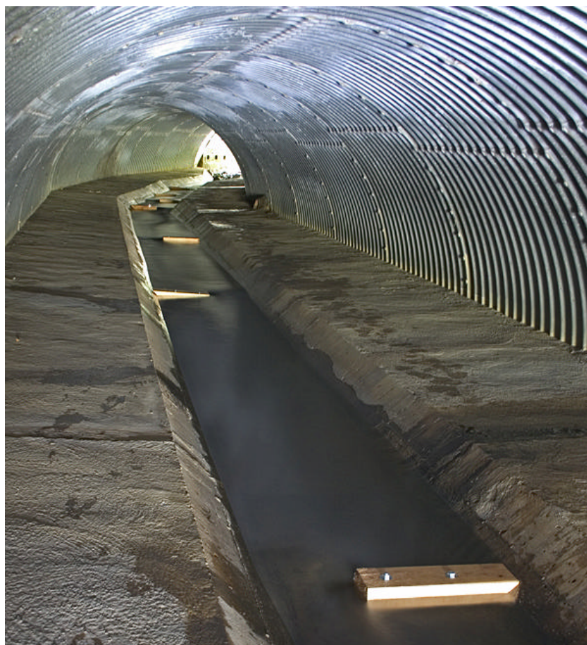
Chenal après l'aménagement
